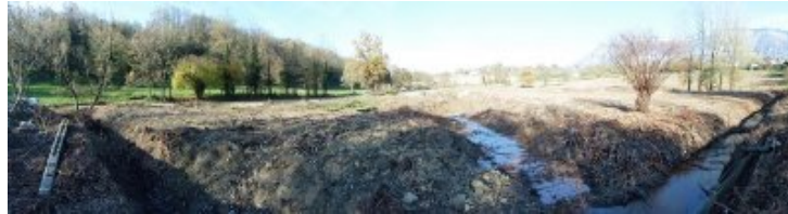
Début des travaux, panoramique des Cavettes en novembre 2015
