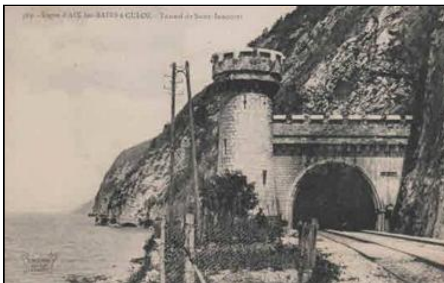
Le tunnel a été élargi pour deux voies mais conserve néanmoins son architecture fortifiée initiale
