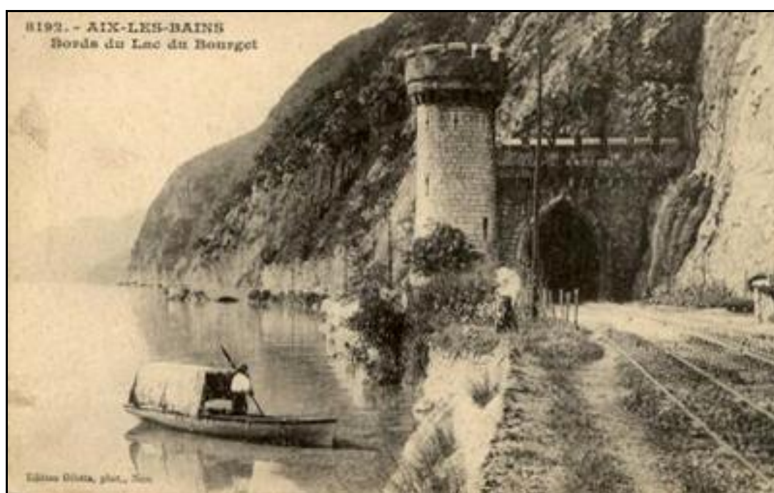
Carte postale ancienne montrant la sortie sud du tunnel du temps où celui-ci était à voie unique Remarquez la voûte en ogive
