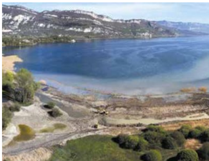
Photo 1 - Reprofilage de la berge par projection de matériaux limono-argileux issus du site (© GREM)
