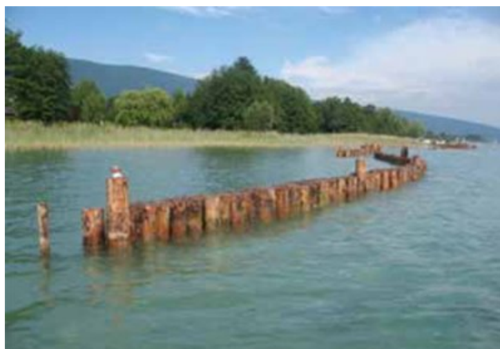
Photo 3 - Ouvrage de protection sur le lac d'Annecy construit à l'aide de pieux jointifs (© D. Zanella - SILA)
