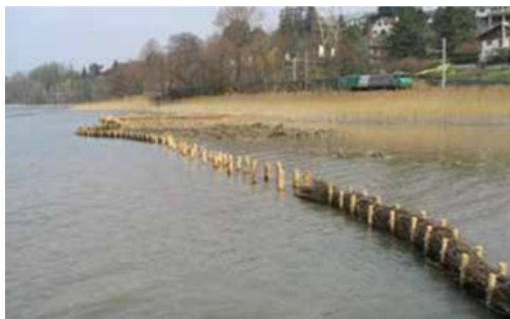
Photo 1 - Fascine végétale pour protéger la roselière de la baie de Mémard au lac du Bourget (© CISALB)
