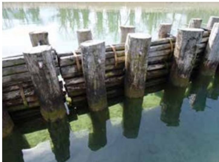
Photo 2 - Ouvrage de protection sur le lac d'Annecy de type « fascine imputrescible » (© D. Zanella - SILA)
