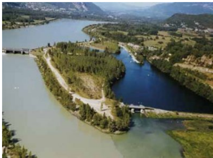
Photo 2 - Les eaux du Rhône sont sur la gauche de la photo. Les eaux du lac du Bourget arrivent sur la droite grâce au canal de Savières (© CNR)
